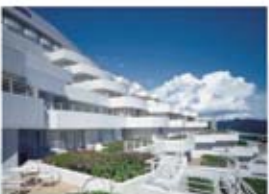
▲エクシブ白浜&アネックス 和歌山県西牟婁郡白浜町
